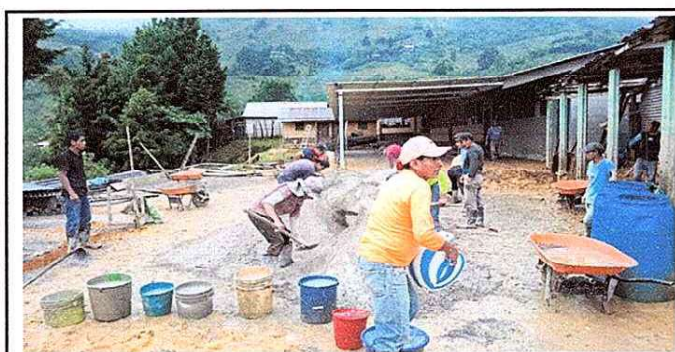
Foto 5: Con el apoyo de Padres de Familia la reparacion y fundicion de torta de concreto del corredor y cocina.
