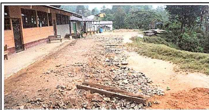
Foto 6: como se muestra en la fotografia la rehabilitacion del corredor y la cocina del establecimiento por el apoyo de los padres de familia.
