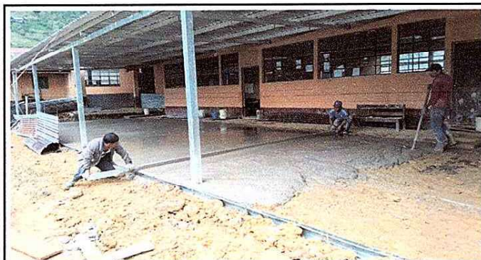
Foto 3: el avance de la fundicion y reparacion de pisos de torta de concreto del corredor del establecimiento.
