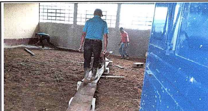
Foto 2. Se evidencia el proceso de traslado de concreto de rehabilitación de entornadode aula de 8x8
