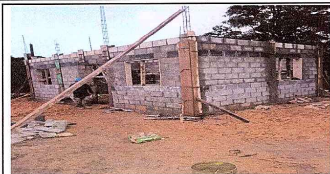
Foto1: se identifica el avance de colocación de columnas de fundición de concreto de la cocina del establecimiento.
